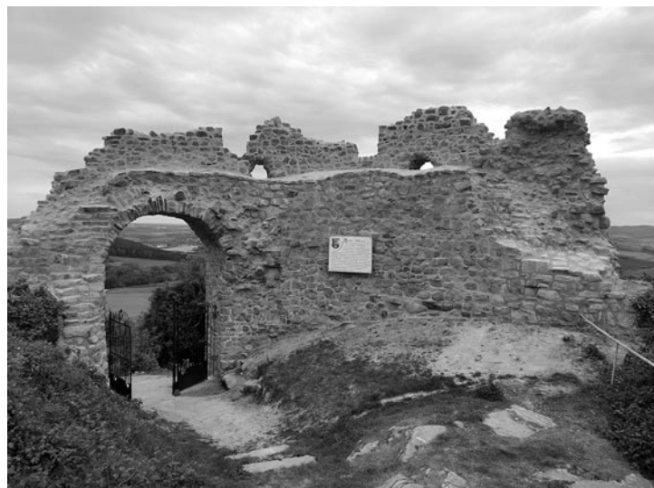
Das renovierte Südtor erstrahlt in neuem Glanz.
